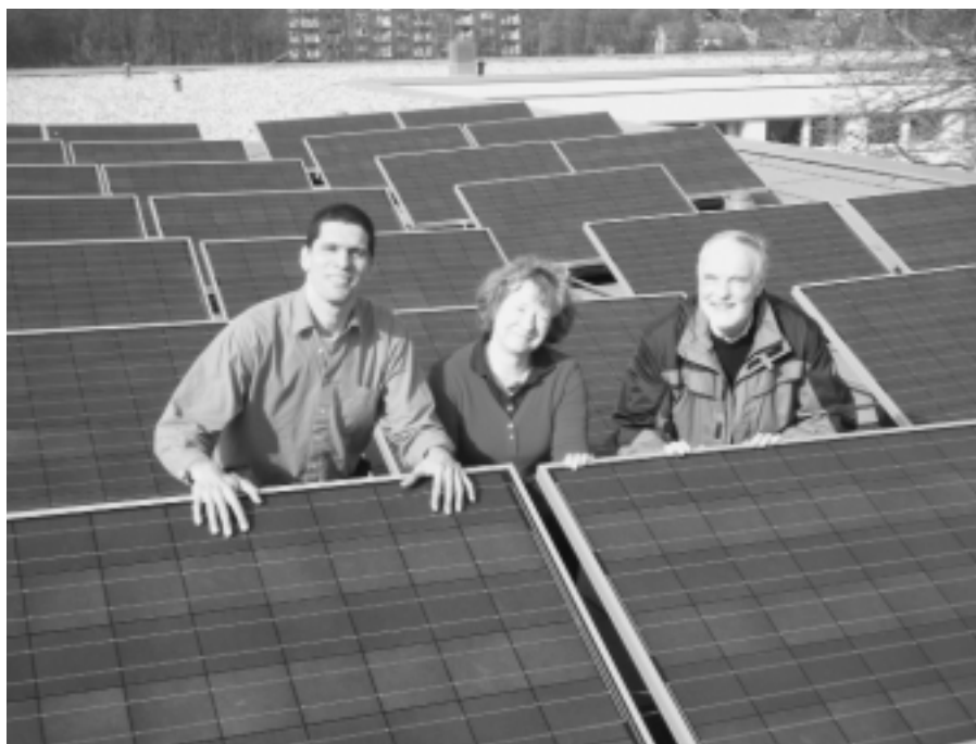
Besichtigen die Photovoltaik-Anlage auf dem Dach der Waldorf-Schule: Marcos A. da Costa Melo, Dagmar Füller und Karl A. Faulenbach.
